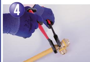
Serrer l'écrou en butée.
